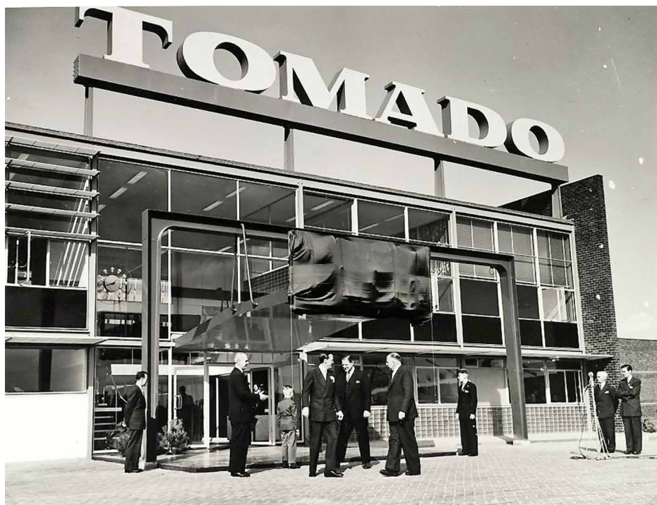
De gesloopte Tomadofabriek in Etten-Leur. (foto Heemschut)
