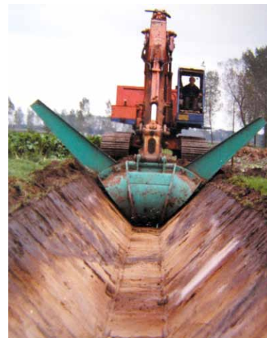
► Grote sloten graven voor een betere afwatering
